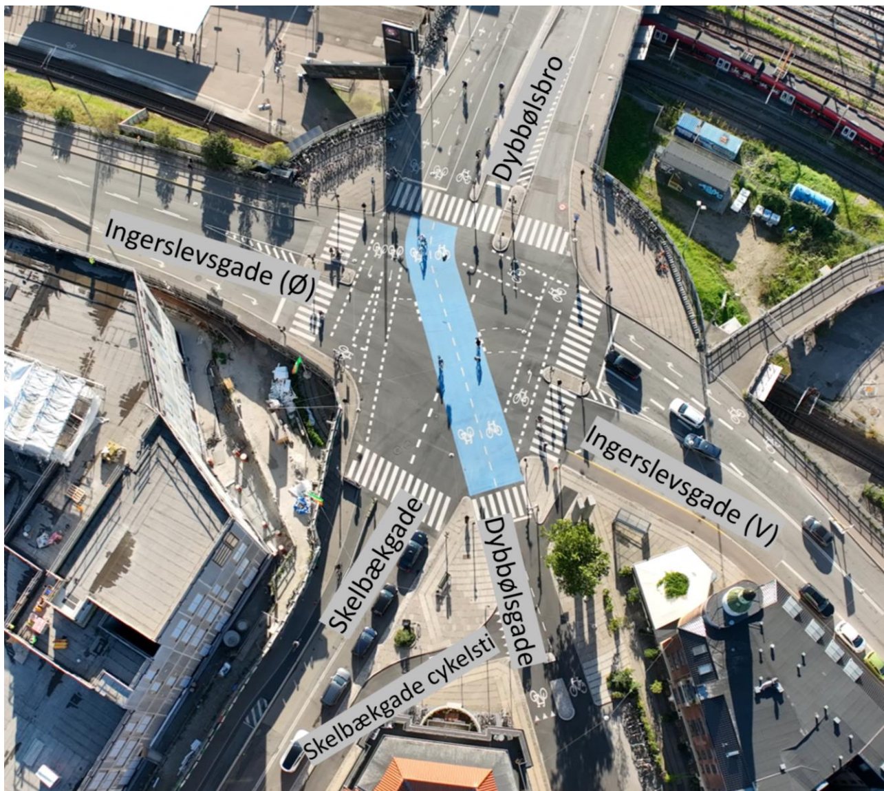
Figur 1 - View fra droneoptagelsen i krydset Dybbølsbro/Ingerslevsgade efter ombygning.
