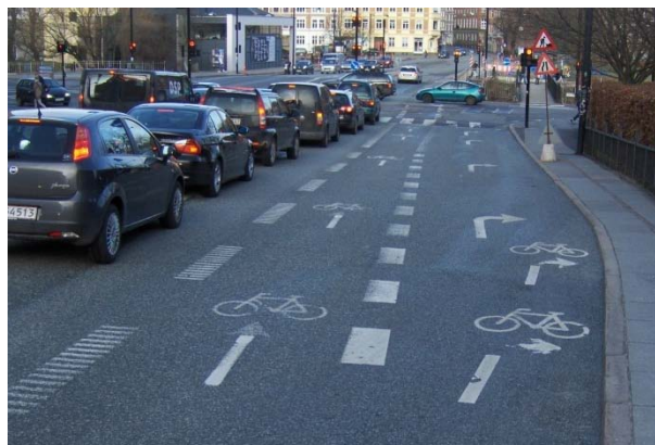
Figur 2. Delvis opmærket cykelbane i højre side i kryds i Århus (Foto: M. Sørensen).
